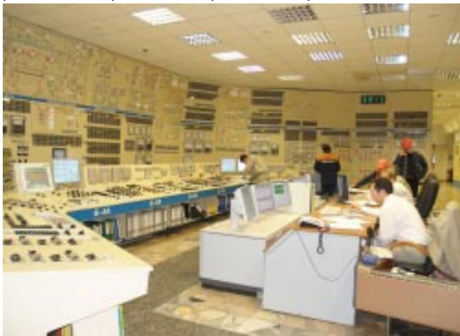
Монтаж модернізованих панелей та пультів на БЦУ енергоблоку №1
